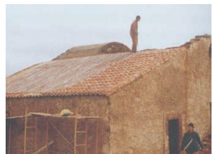
Execução de um telhado constituído por telha argamassada e assente num “encaniçado” – Cabeço de São Barão, Mértola e Alte, Loulé
