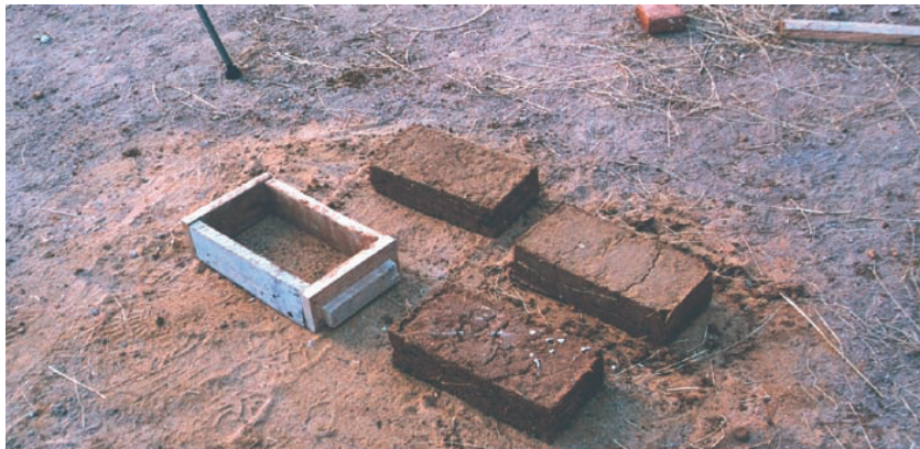
Manufatura de tijolos de adobe através de moldes em madeira
