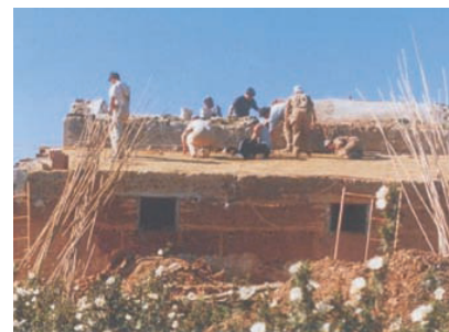
Execução de paredes de taipa - Cabeço de São Bernardo, Mértola
