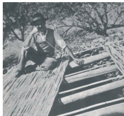
Execução de um telhado constituído por telha argamassada e assente num “encaniçado” – Cabeço de São Barão, Mértola e Alte, Loulé
