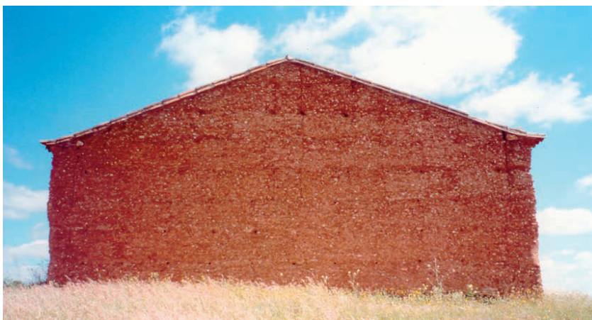
Parede de taipa antiga sem protecções: sem botas, com chapéu deficiente, sem pele
