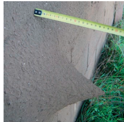
8. Cone de terra acabado de projectar, mostrando a excelente coesão do material, resultante da compactação inerente à técnica utilizada
