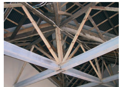
Reforço com estrutura mista da cobertura do 2.º piso
