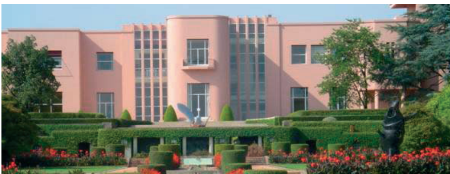
Aspecto final da obra
