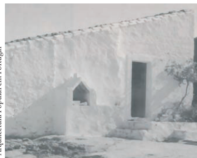
Duas habitações situadas em Alcoutim, serra do Caldeirão, onde podemos observar a ocupação de diferentes níveis do solo e a existência de fornalha exterior adossada à fachada
