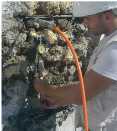
5 - Zona de ensaio de macacos planos da parede resistente de alvenaria
