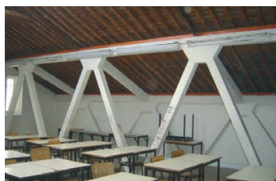
2 - Alterações estruturais, com elementos de betão armado
