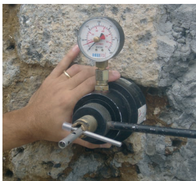
7 - Ensaio de arrancamento de uma hélice na alvenaria
