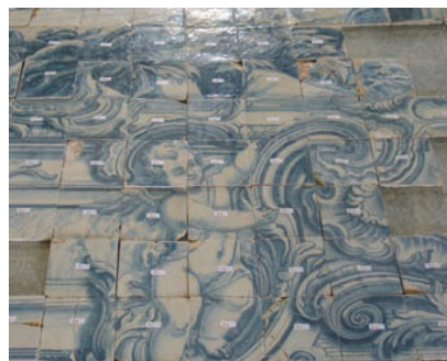
Durante a intervenção de reabilitação
