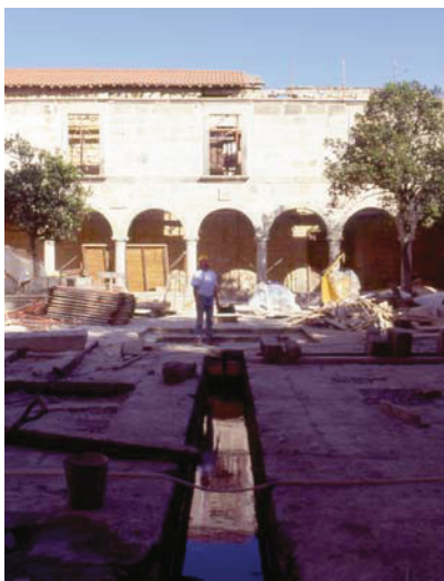
Pousada de Santa Maria do Bouro – Reabilitação integral enquanto conjunto patrimonial reactivoando o sistema hidráulico ancestral. Arq.º Souto Moura
