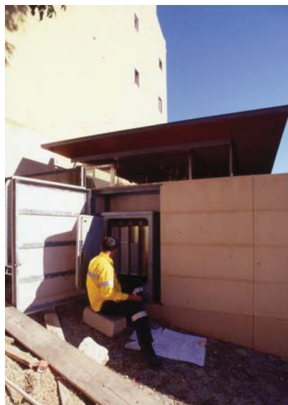
Castelo de S. Jorge, Caminho de Ronda – “Falso muro” infraestruturado por módulos. E.D.P., T.L.P., Tv Cabo, etc.. D.G.E.M.N. Arq.º Victor Mestre
