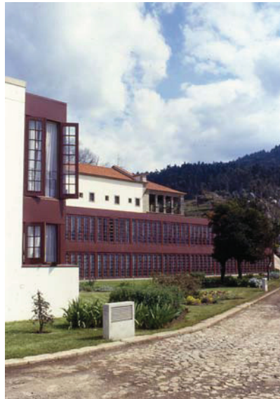
Pousada de Santa Marinha de Guimarães – projecto paradigmático de intervenção e infraestruturação em património histórico. Arq.º Fernando Távora
