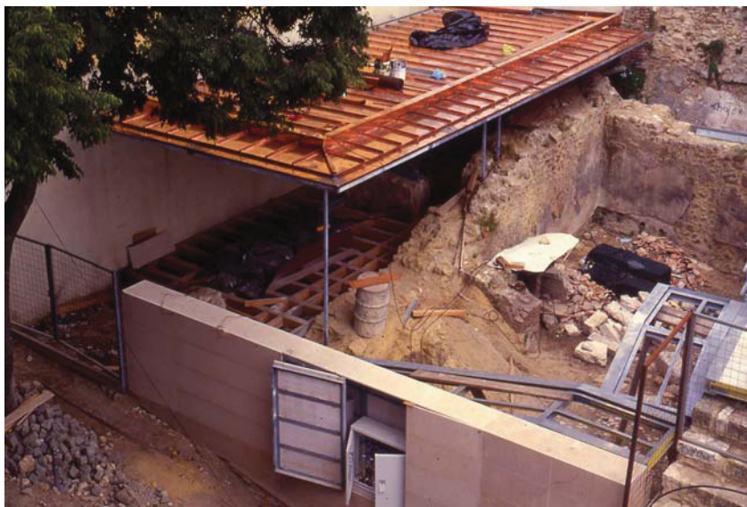
Castelo de S. Jorge, Caminho de Ronda – “Falso muro” infraestruturado por módulos. E.D.P., T.L.P., Tv Cabo, etc.. D.G.E.M.N. Arq.º Victor Mestre
