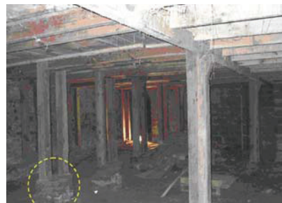
Figura 3 – Estrutura sob o palco constituída por pilares e vigas de madeira. Pormenor das fundações de basalto
