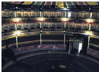
Figura 1 – Vista do Circo antes da intervenção de reabilitação
