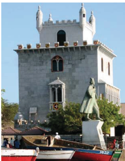
1 - Vista geral após a intervenção de recuperação
