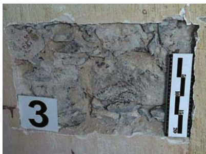
3 – Pormenor de sondagem numa parede, expondo a alvenaria
