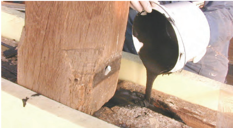
Vazamento de calda epoxídica para reconstituição das secções.
