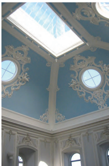
Tecto interior da Cúpula após reparação e pintura dos estuques
