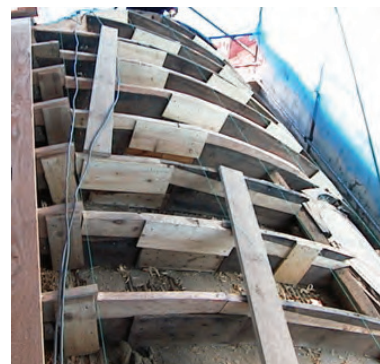
Fase de recuperação e reparação da estrutura
