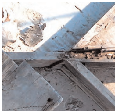
Pormenor do estado da estrutura após remoção dos revestimentos
