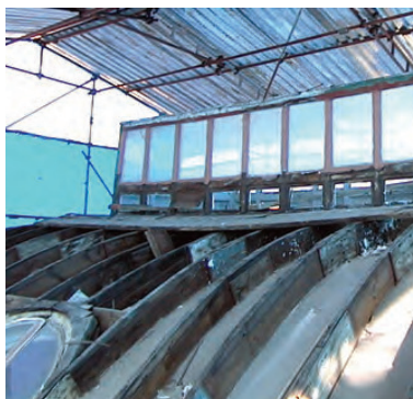
Estado da estrutura após remoção dos revestimentos
