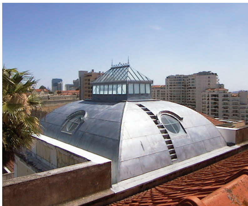
Vista geral da Cúpula concluída
