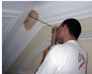
3 – Observação endoscópica do interior da estrutura da escada
