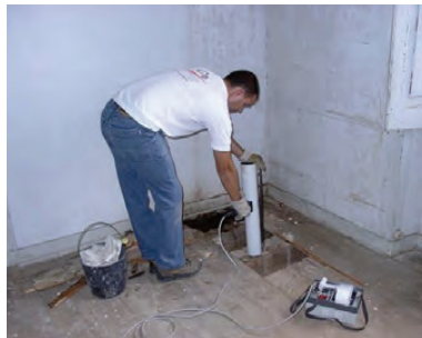
2 – Ensaio para avaliação da integridade dos vigamentos de madeira através da técnica da resistografia
