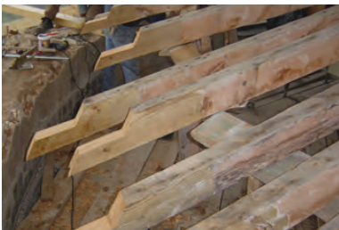
Tratamento de vigas por empalme
