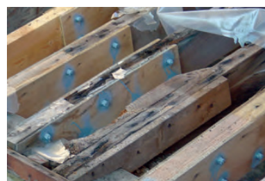
Exemplo de tratamento de apoio de vigas
