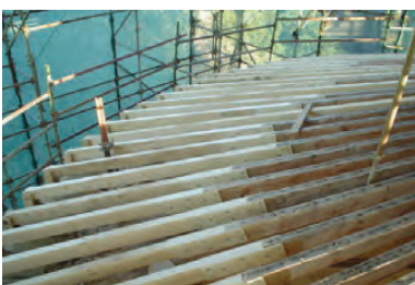
Aspectos da zona do Torreão Sul após recuperação das vigas
