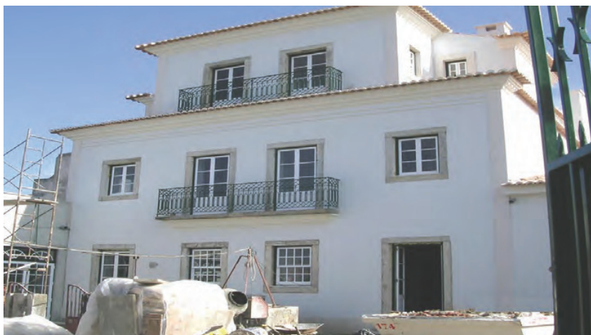
Aspecto geral da estrutura de piso
