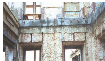
Fase de fixação das cintas por pregação
