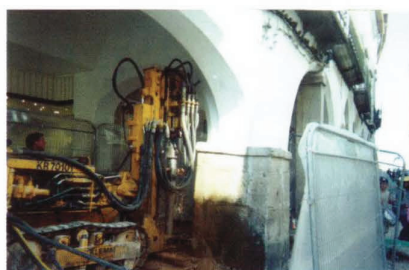
Execução da furação das microestacas
