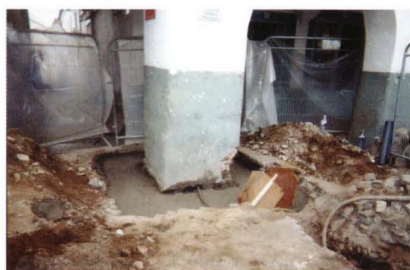
Maciço de encabeçamento das microestacas
