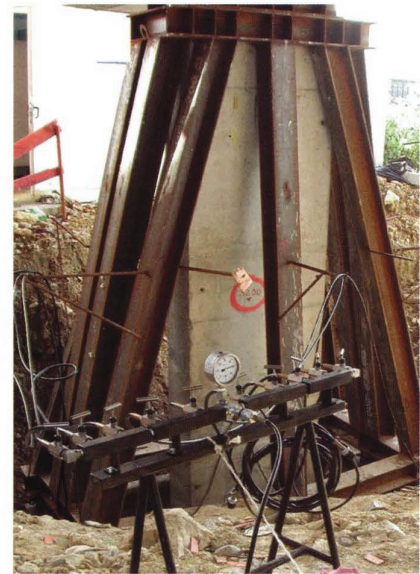
Fig. 7 – Estrutura metálica para colocação das microestacas em carga
