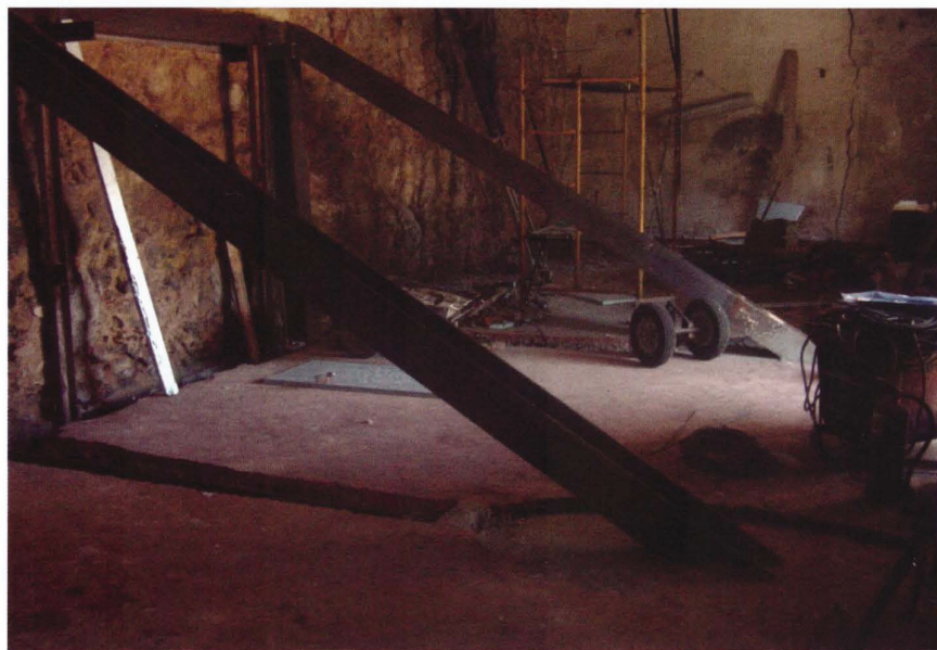
Fig. 3 – Palácio dos Condes da Lousã, Damaia. Escoramento da parede de suporte de terras interior
