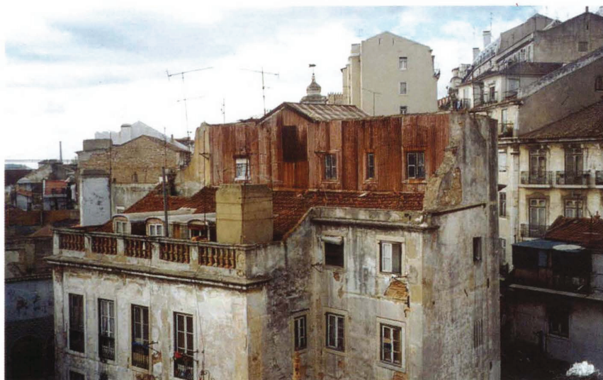
Fig. 2 – Chafariz d'El Rei, Alfama. Edifícios vizinhos
