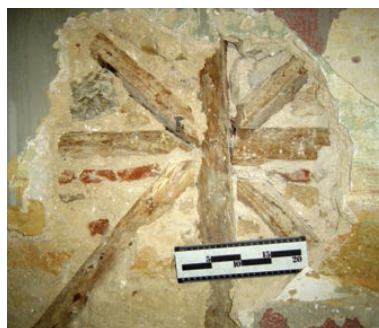
Fig. 2 - Sondagem. Parede de “frontal”
