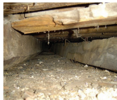
Fig. 3 - Sondagem. Pavimento em madeira
