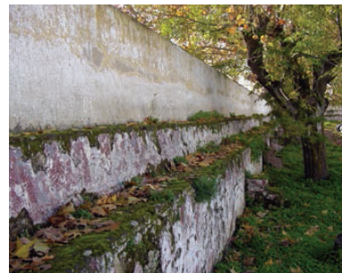
Fig. 2 - Vista geral do adarve antes da intervenção
