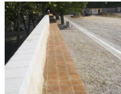
Fig. 3 - Vista geral do coroamento, adarve e sistema de drenagem interior, após a intervenção
