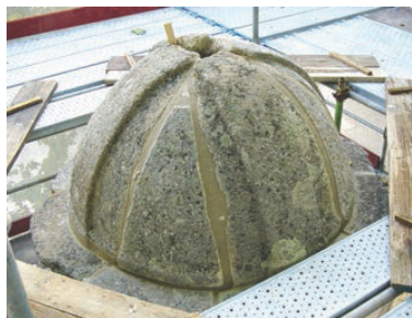
c) Refechamento das juntas da cúpula da guarita
