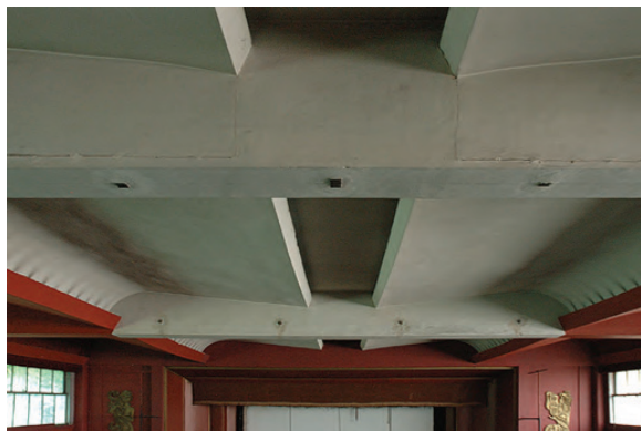
Utilização de extensas vigas em betão para suporte da cobertura (obra arrojada do eng.º Bêlard da Fonseca)
