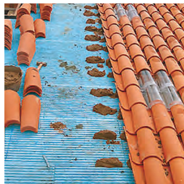
Fig. 7 - Reforço do isolamento térmico em coberturas inclinadas
