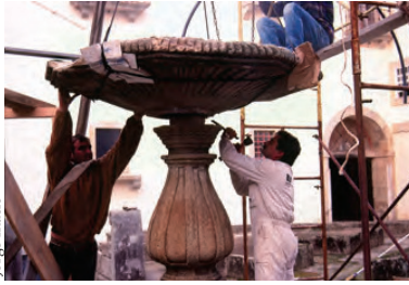
O conservador restaurador trabalha com o canteiro na recuperação do Chafariz de São João
