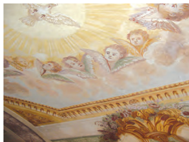
Fig. 2 - Vista geral da zona de fecho da abóbada, após conclusão da intervenção
