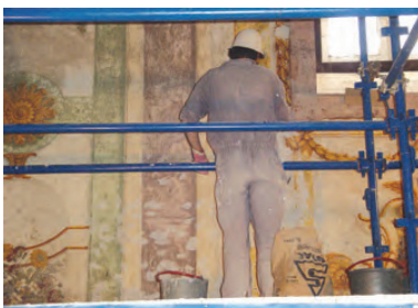
Fig. 1 - Colmatção de lacunas e preenchimento de fendas existentes (antes da intervenção)
