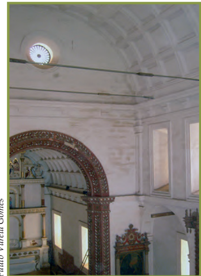
A Capela do Monte hoje: interior, vendo-se dois dos tirantes de aço
