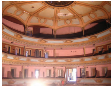
Aspecto geral da sala antes da intervenção
