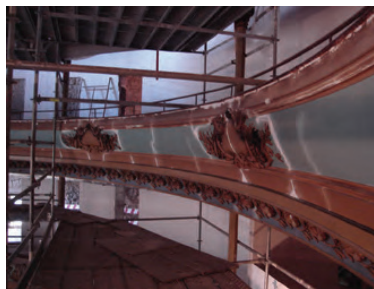
Consolidação, reintegração volumétrica e nivelamentos das superfícies minerais lisas e ornamentais
