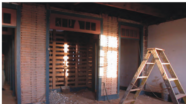
Remoção dos rebocos
