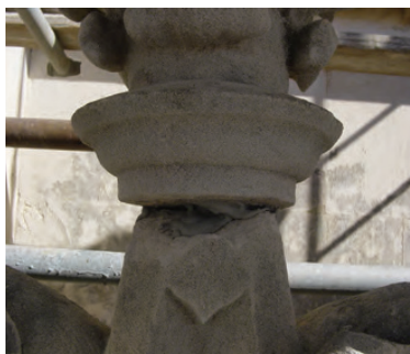
4 - Colagem estrutural de elementos salientes com argamassa de base epoxídica
