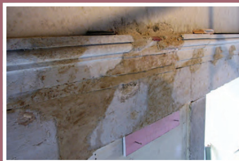
Sanca de cantaria em fase de restauro
