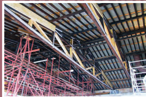
Asnas reforçadas e plataforma de acesso aos trabalhos
