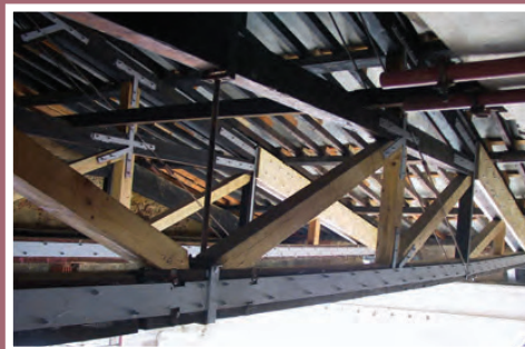
Asna de madeira reforçada
