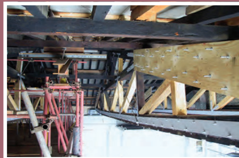
Asna de madeira reforçada e apoio com macaco hidráulico
