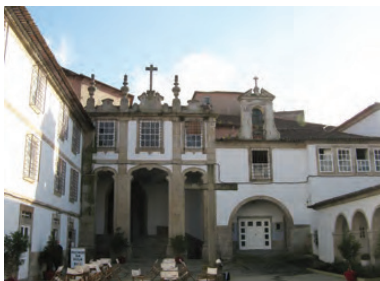
1 - Vista da capela de Corpus Christi
