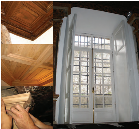
4 - Vários aspectos da intervenção nos tectos
