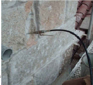
Paredes exteriores da torre - injeção das fissuras das pedras (resina de poliéster e resina epoxi)
