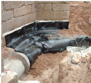
Sistema de ventilação exterior da base das paredes
