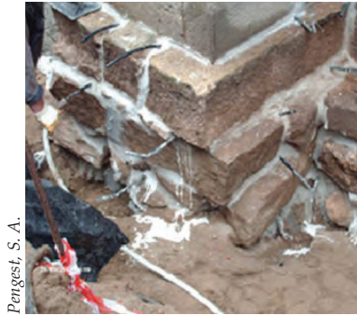
Contraforte da parede sul - consolidação superficial de fundações; - injeção de calda Albaria Iniezione
