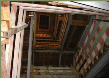
8 – Reforço da estrutura das escadas
