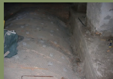
5 - Reparação de fissuração de abóbadas
