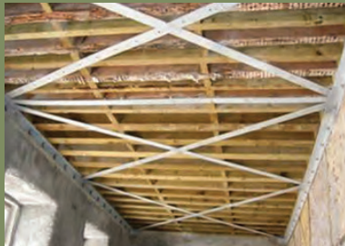
6 – Reforço inferior dos pavimentos através de cantoneiras e perfis de aço
