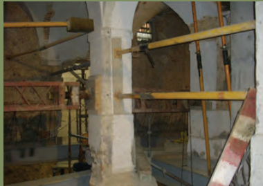
2 – Escoramento de arcos e abóbadas para colocação de estrutura metálica no primeiro sobrado
