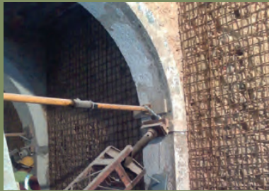
4 – Arcos torais escorados e pregados às paredes laterais
