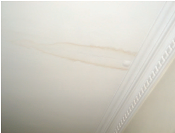
6 - Anomalia. Tipologia: fissuração (0,85mm); localização: juntas; extensão: elevada; urgência na reparação: máxima
