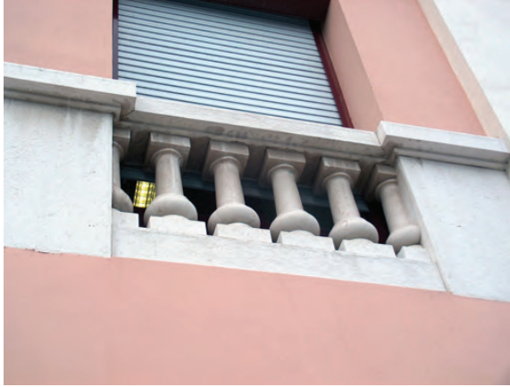
2 - Anomalia. Tipologia: acumulação de sujidade; localização: zona inferior das pilastras das janelas; extensão: média; urgência na reparação: média
