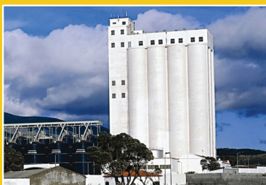
O Silo de cereais de Lagoa, S. Miguel (Açores), após a intervenção.
