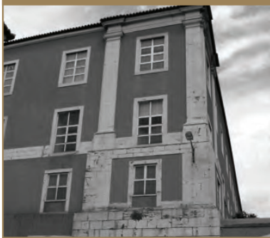
Ángulo SE da fachada do Mosteiro.
