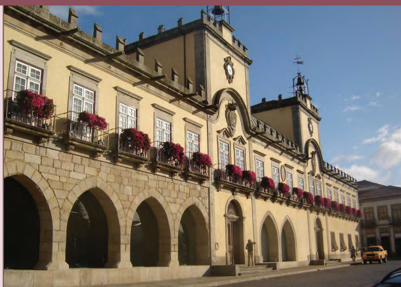
1 - Vista actual da fachada principal do edifício da Câmara Municipal de Barcelos.
