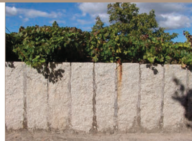
Muro em pasta (Campos, Vila Nova de Cerveira).
